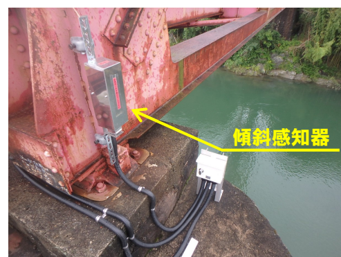
図-3 センサ設置状況
