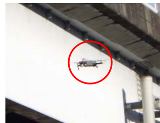
写真-2 点検状況
