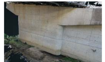
点群データ (橋脚)
