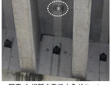
写真-4 桁間を飛行するドローン
