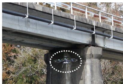
写真-3 調査状況
