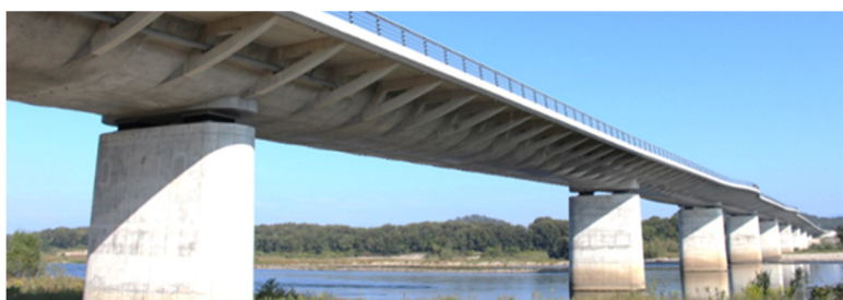
図-1 各務原大橋(10径間連続フィンバックPC橋)
