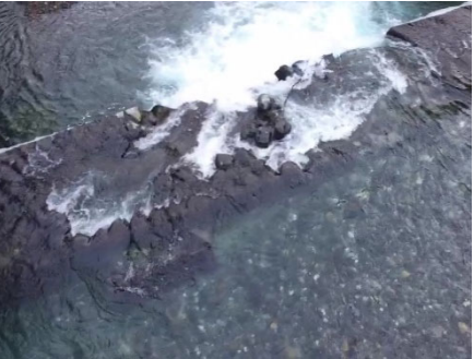
(e) 今回点検天端（UAV 撮影）
