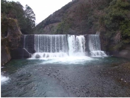
(f) 今回点検堤体（UAV 撮影）
