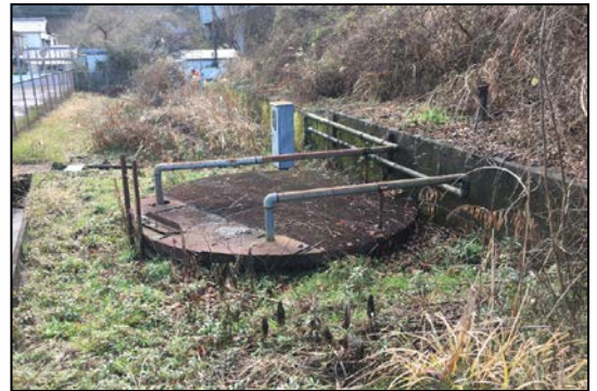
写真-1 鋼製集水井
