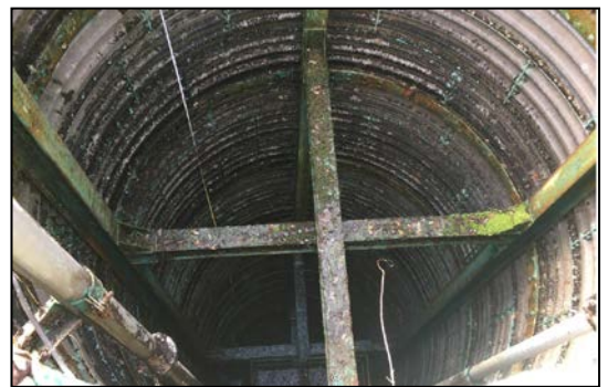
写真-2 集水井坑内状況
