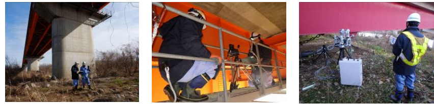
写真-1 橋梁定期点検への本技術の活用状況
