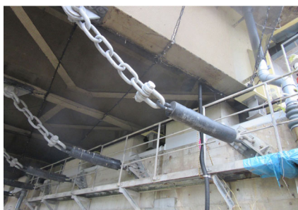
写真 2 落橋防止装置設置状況
