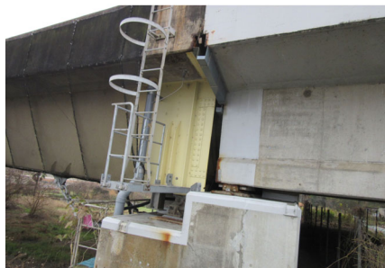
写真 1 実証試験橋梁桁端部
