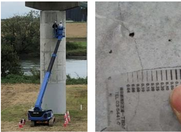
図－5 高所作業車による近接目視状況
