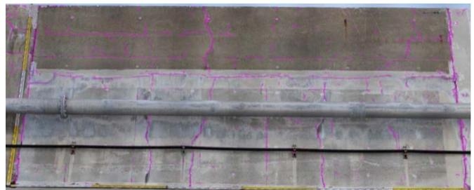
図2 YoLoによるひび割れ検出結果
