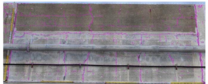
図7 画像処理適用後のひび割れ検出結果
