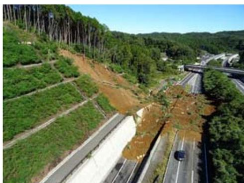
写真1. のり面崩落状況
