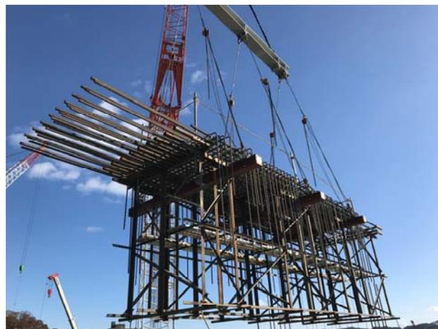
写真-1 中央ブロックの架設状況
