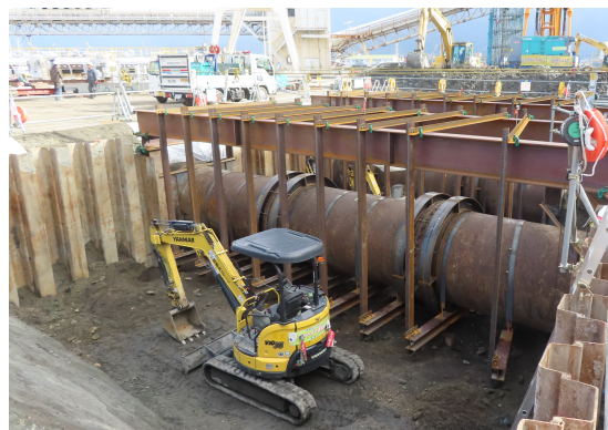
図-8 吊防護設置完了
