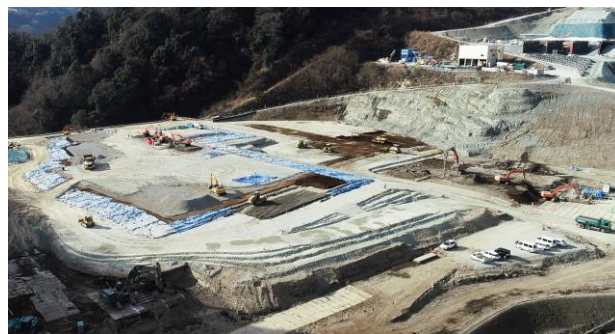
図－6 盛土場状況（全景）
