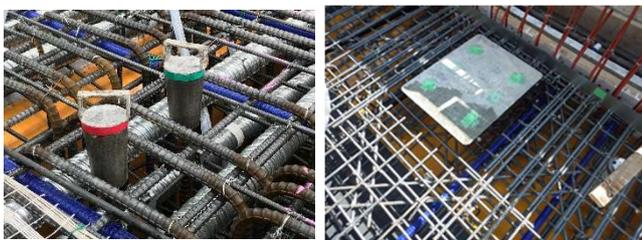
図-1 移動作業車アンカー (左)、排水柵 (右)
