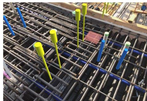
図-5 埋設物確認状況
