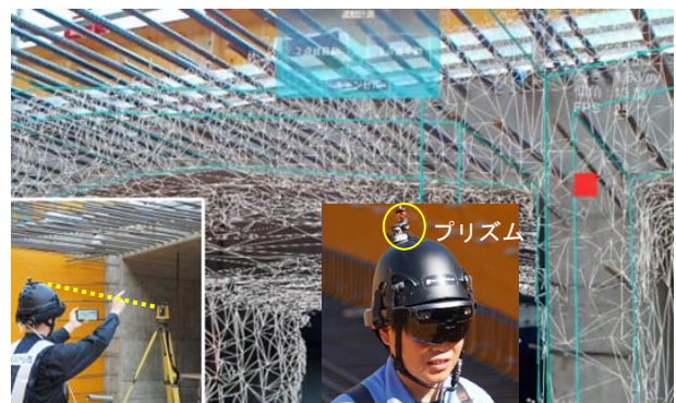
図-2 MR 技術による型枠・出来形検査状況
