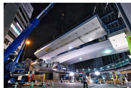
写真 4 クレーンによる架設状況
