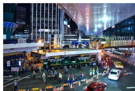
写真 5 多軸台車による架設状況
