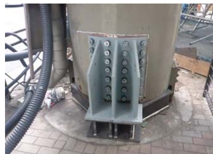
写真3 橋脚基部ヒンジの剛結補強
