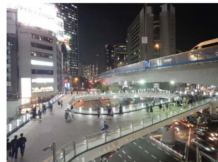
写真 7 完了全景(夜間)
