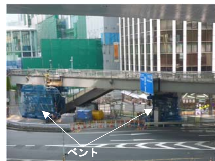
写真2 ベントによる仮受
