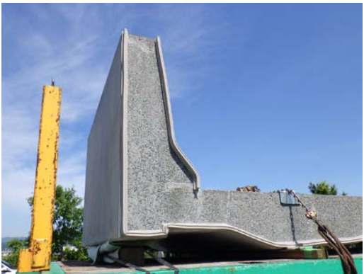
図-4 プレキャスト床版(壁高欄一体)
