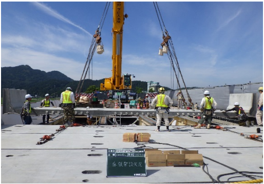
図-5 床版設置状況(250tATC)
