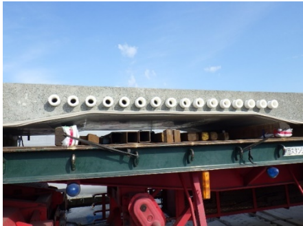
図-2 PC 継手構造（縦締め方式）
