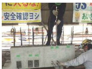
写真-5 切断状況
