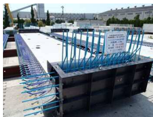
写真-1 地覆部の先行施工
