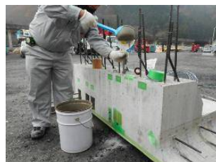
写真-8 充填状況
