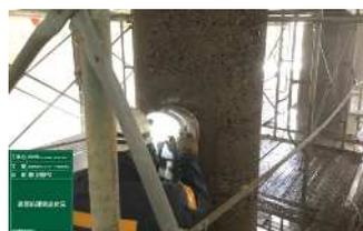
写真-5 表面処理工
