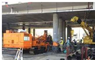
写真-3 補強杭施工状況
