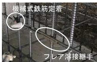
写真-7 帯鉄筋定着・継手
