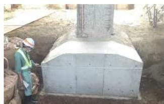
写真-4 底版拡幅完了
