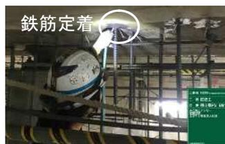
写真-6 軸方向鉄筋定着
