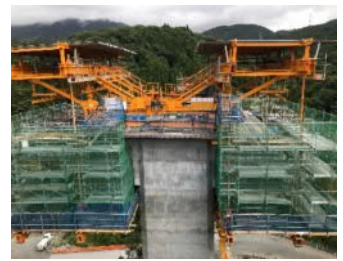
写真4:移動作業車組立(2) (合理化施工)
