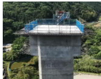
写真2:柱頭部施工完了 (合理化施工)
