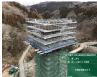
写真1:足場支保工組立 (合理化施工)
