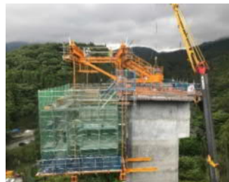
写真3:移動作業車組立(1) (合理化施工)
