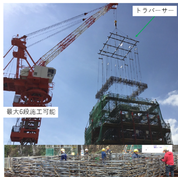
写真-2 帯鉄筋の組立・架設状況
