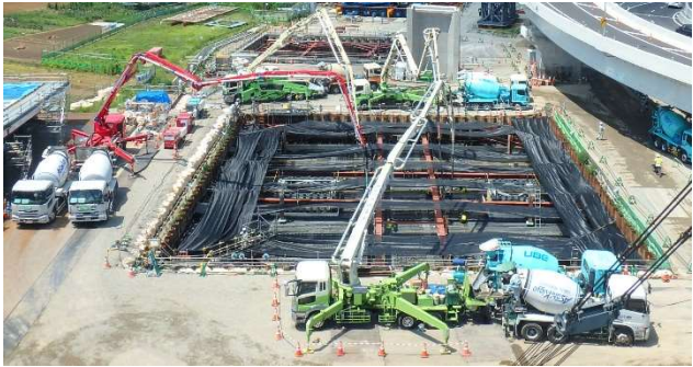
写真-1 PH 本 18 打設状況
