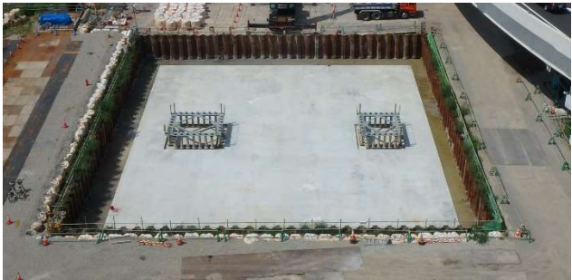
写真-2 PH 本 18 基礎完成全景
