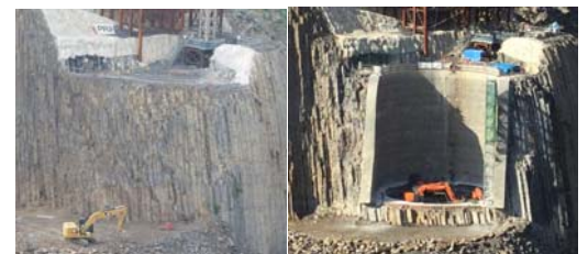
写真-1 土留め壁施工前後の状況
