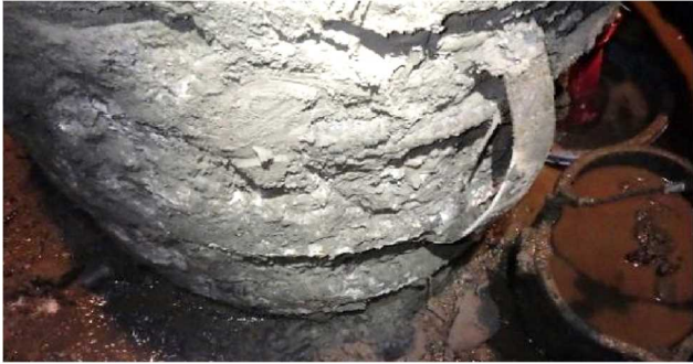
写真-1 コンクリート充填状況 (No. 4 杭 西側 杭頭-4.5m 付近)
