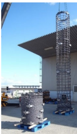
写真－1 伸縮式鉄筋かご
