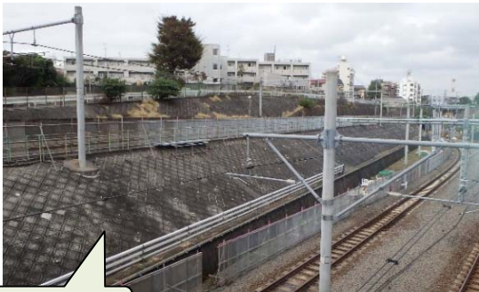
施工対象のり面
