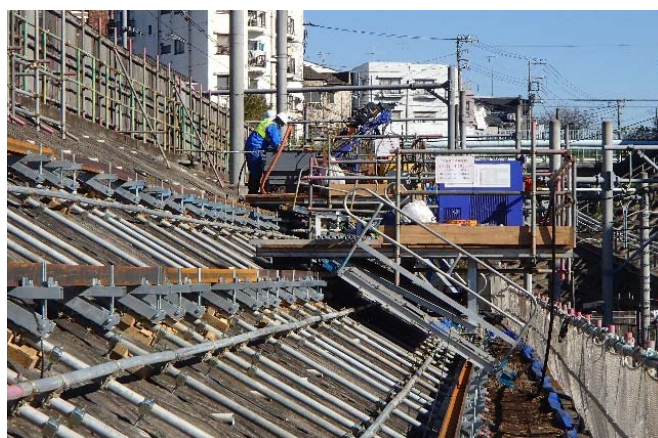
写真-5 小径棒状補強施工中
