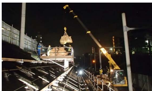
写真-2 土砂土嚢運搬
