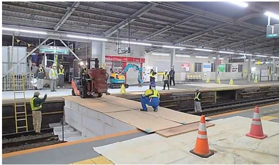
写真-1 軽量盛土材による線路横断通路の設置状況
