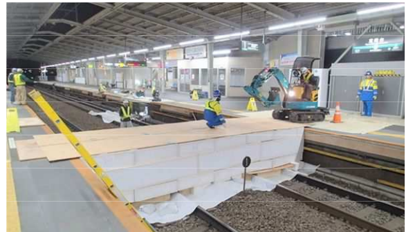
写真-1 軽量盛土材による線路横断通路の設置状況
