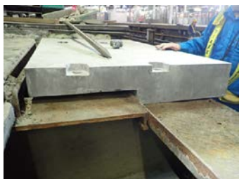
写真-2 ダクト板断面
