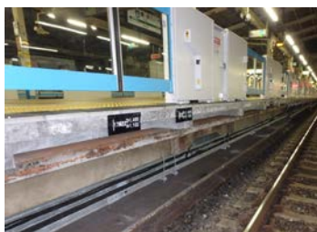
写真-3 施工完了
