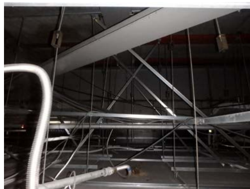
写真-1 天井裏配線・配管状況
