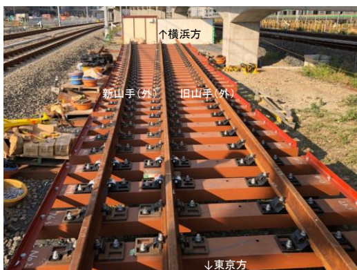
図-5 長マクラギの仮組状況
