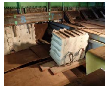
写真-2 引出し後の状況
