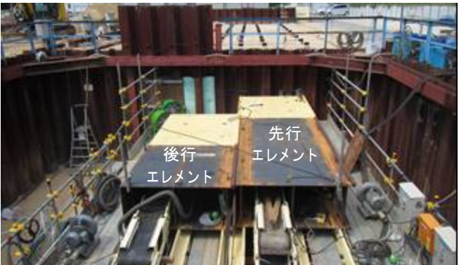
写真 - 1 性能確認試験状況（発進立坑）
