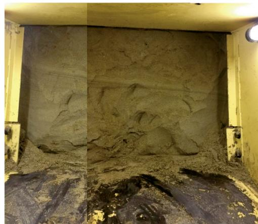
図-4 切羽状況（人力掘削）
