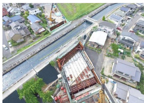
写真-4 函体推進状況
