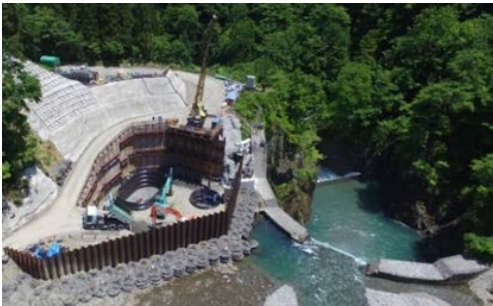
写真-1 工事場所と近接するアーチ式砂防堰堤
