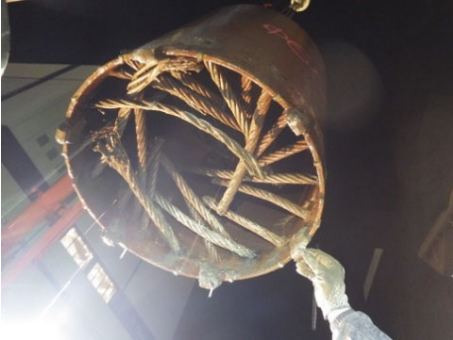
写真－2 取込みビット
