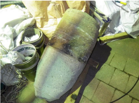
写真－4 残置コンクリート
