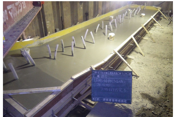
写真-1 キャッピング躯体打設状況写真
