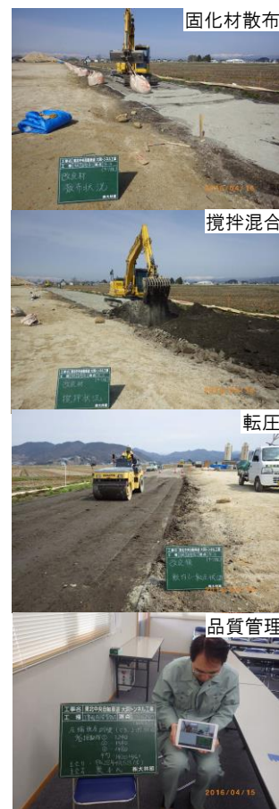
写真-2 工事用道路の施工
