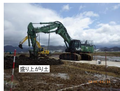
写真-1 中層混合処理工施工状況
