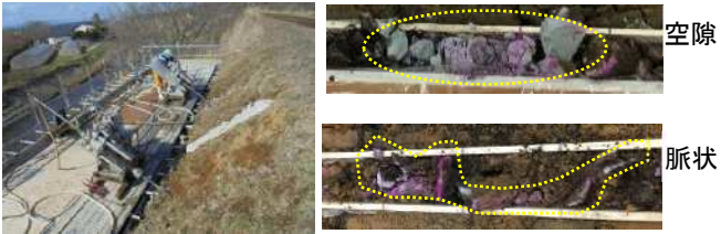
図-6 （左）施工状況写真・（右）コア観察
