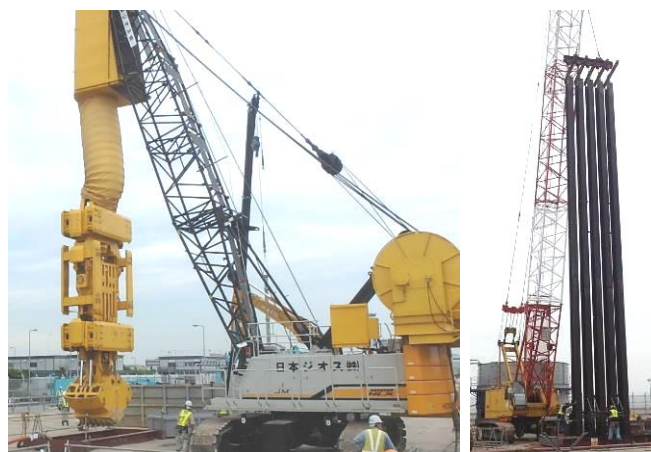
写真-2 地中連続壁工 施工状況
