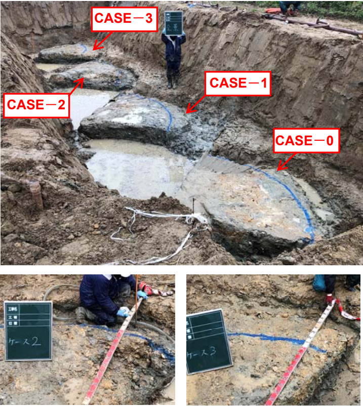
写真1 改良体（材令14日）
