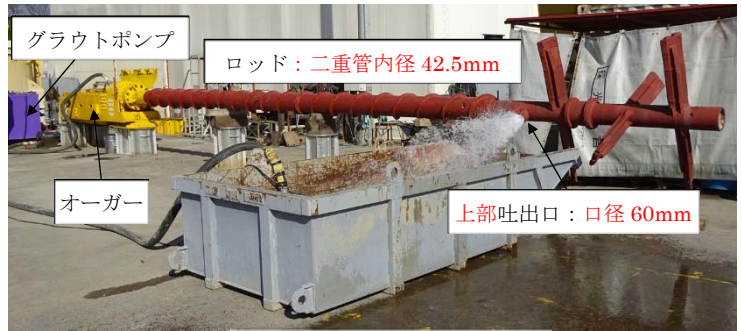
写真-1 通水試験状況
