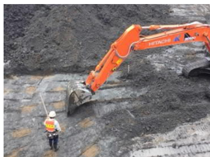
写真-1 掘削深さ管理のイメージ
