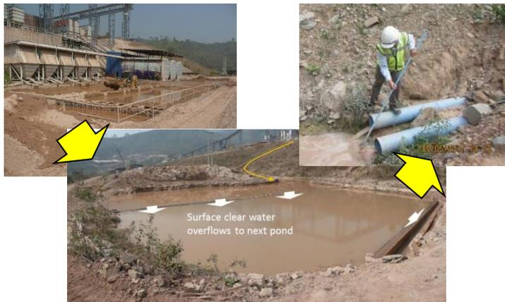
写真－3 生コンプラント濁水処理設備
