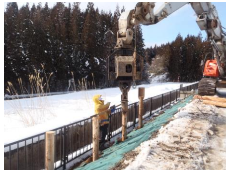
写真-2 木杭打設状況
