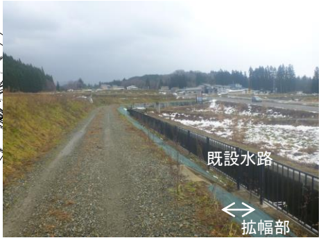
写真-1 施工前状況（施工区間③）
