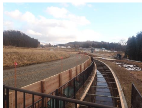
写真-3 施工完了
