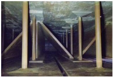
写真-2 既設躯体の内部状況
