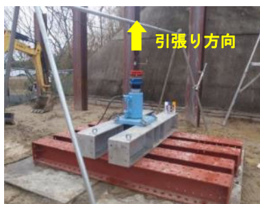
写真-3 試験施工状況
