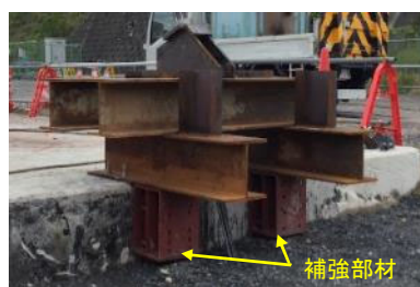
写真-4 アンカー架台の設置状況
