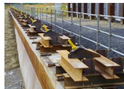
写真-5 アンカー設置状況
