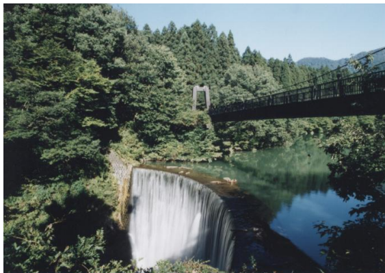
写真-1 大源太川第1号砂防堰堤
