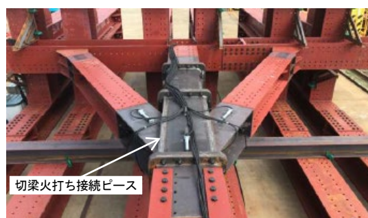
写真 1 切梁火打ち接続ピース
