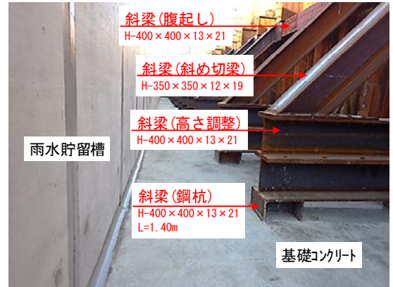
写真2 斜梁設置状況
